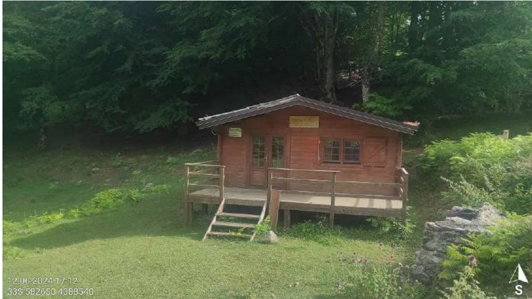
Figura 7 Infrastrutture lungo percorso
